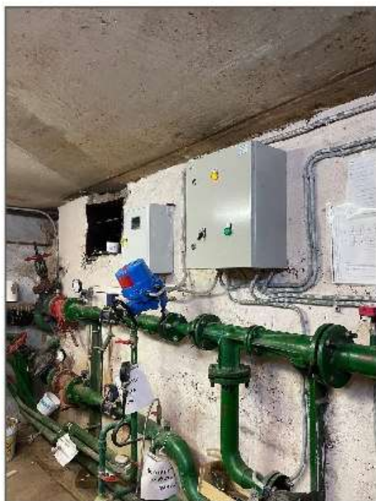
Рисунок 5.3.10 – Тепловой узел и тепловычислитель ВЗЛЕТ
