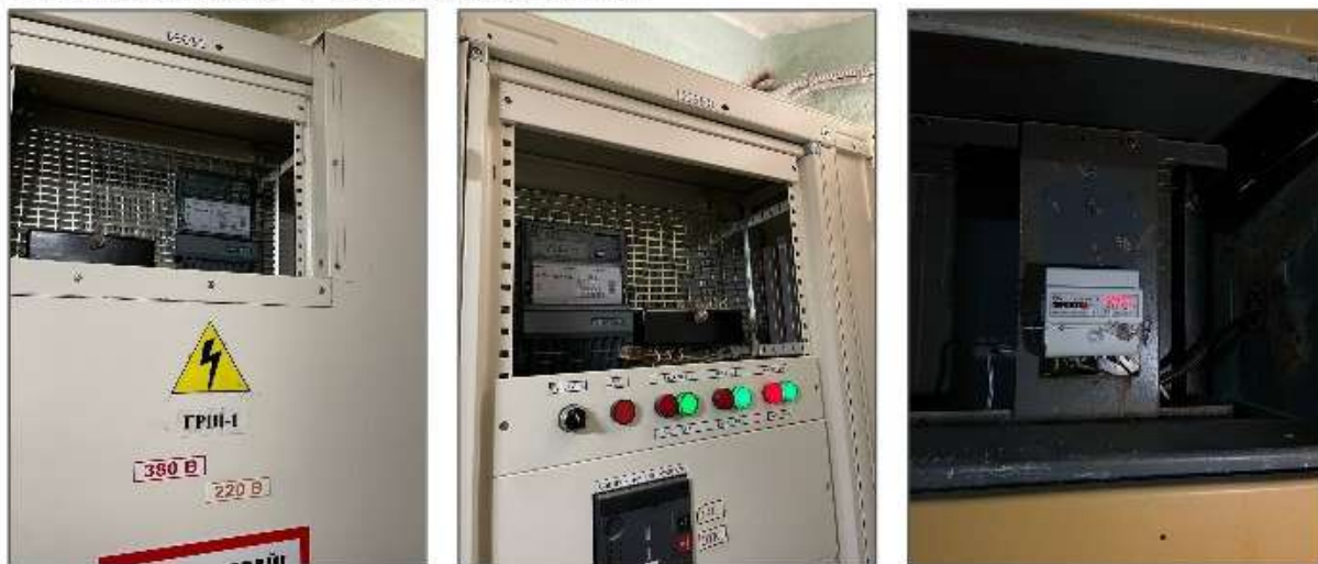
Рисунок 5.3.9 – Приборы учета электрической энергии
