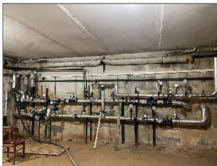
Рисунок 5.3.4 – Тепловой узел и тепловычислитель ВЗЛЕТ
