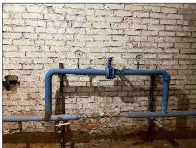
Рисунок 5.3.5 – Водомерный узел и прибор учета СВК-20У
