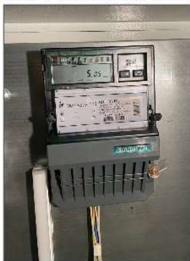
Рисунок 5.3.3 – Приборы учета электрической энергии
