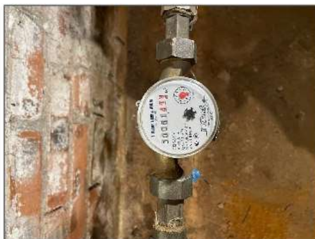
Рисунок 5.3.5 – Водомерный узел и прибор учета СВК-20У
