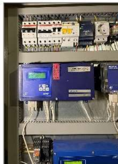
Рисунок 5.3.4 – Тепловой узел и тепловычислитель ВЗЛЕТ
