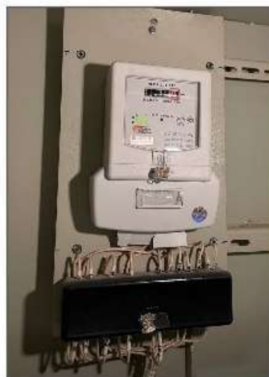
Рисунок 5.3.3 – Приборы учета электрической энергии
