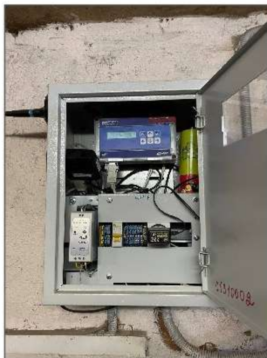
Рисунок 5.3.10 – Тепловой узел и тепловычислитель ВЗЛЕТ
