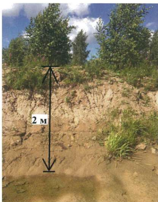
Рис. 2. Существующая обваловочная стенка: А – фото в натуре, Б – параметры: высота, угол наклона, крутизна откоса (отношение его высоты к заложению)
