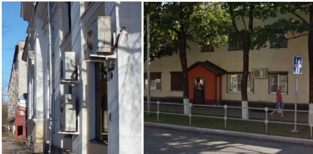
Рисунок 12. Водосточные трубы, кондиционеры
